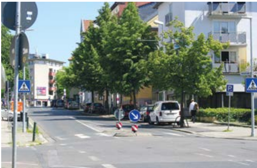
Die untere Helmstedter Straße, Situation im Mai 2024. Für Braunschweiger Verhältnisse besitzt die Straße im ersten Teilstück eine beachtliche Steigung. Auf der Kuppe zweigt nach links die Kastanienallee ab.
