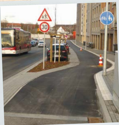
Neuer Radweg an der Stadtstraße Nord im 'BS-Standard' mit baulichem Trennstreifen zur Fahrbahn und zum (Längs-)Parken.
