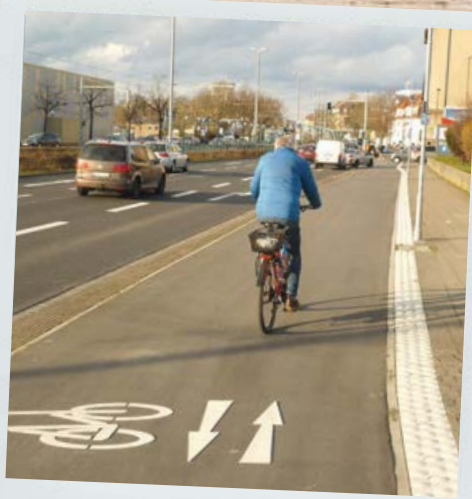
Breiter Radweg für 2-Richtungs-Radverkehr an der Hamburger Straße mit Noppensteinen zum Gehweg hin.
