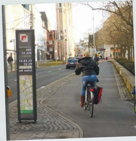
Umbau des ehemaligen Gehweges an der Wendenstraße zu einem breiten Zwei-Richtungs-Radweg mit Radlerzählstelle.
