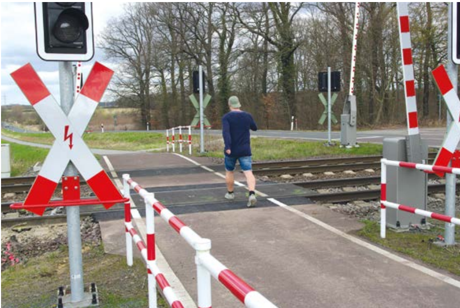
Die Neugestaltung des Bahnübergangs mit einer abgetrennten Furt für Fußgänger und Radfahrer.
